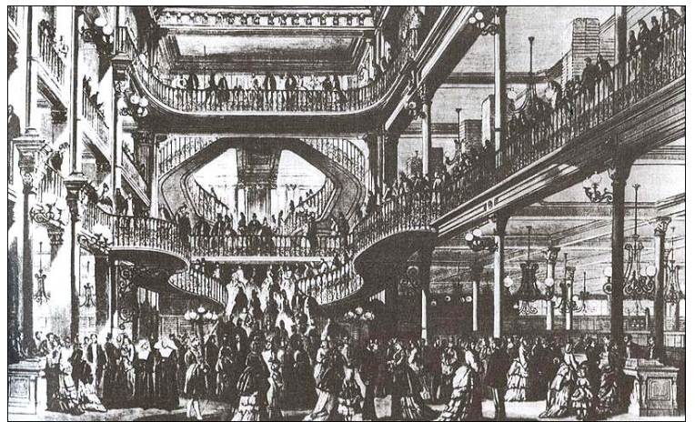
Dans un grand magasin parisien : les colonnes et poutrelles sont en fonte (un métal).
